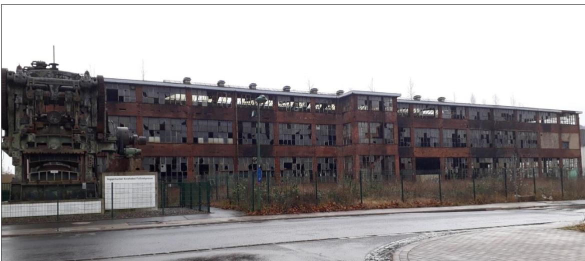
Werksgebäude O1, Straßenansicht Friedrich-Naumann-Straße
