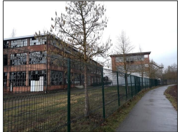
Nördlicher Abschluss des Geländes, Fußweg entlang der Hörssel
