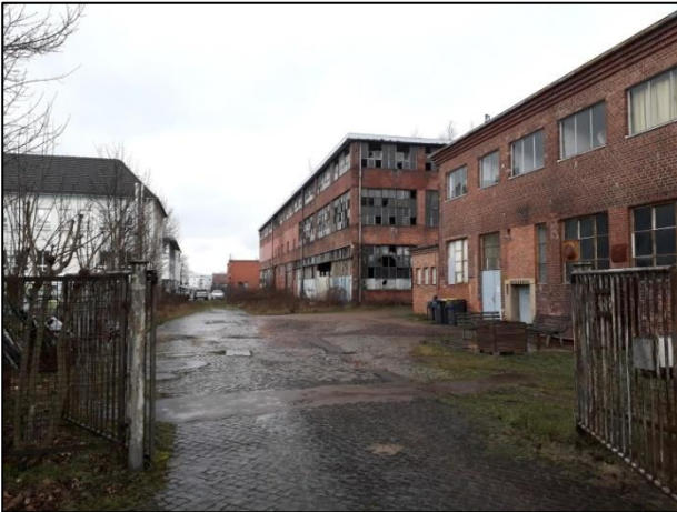
Werksgebäude O1, mit Vereinsgebäude im Vordergrund
